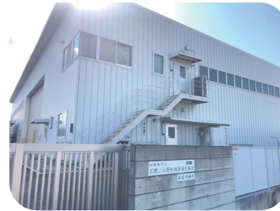
写真：部屋中継施設
